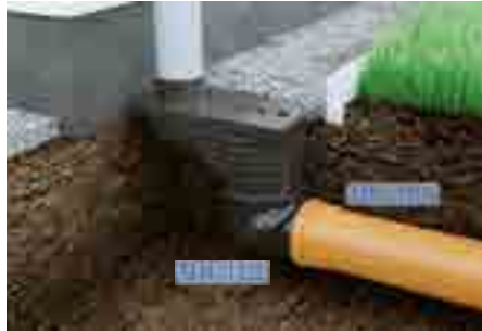
5. Kanalizasyon borusunu bağlayın DN110 - doğrudan DN125 - kesin!
